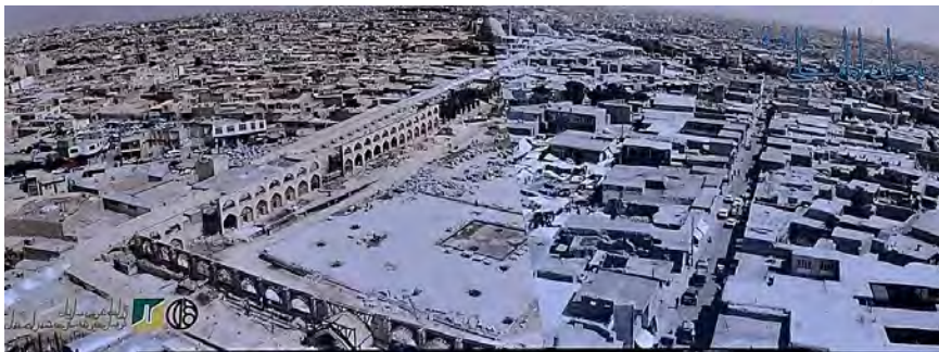
وضعیت قبل و حین اجرای پروژه در محدوده میدان عتیق
