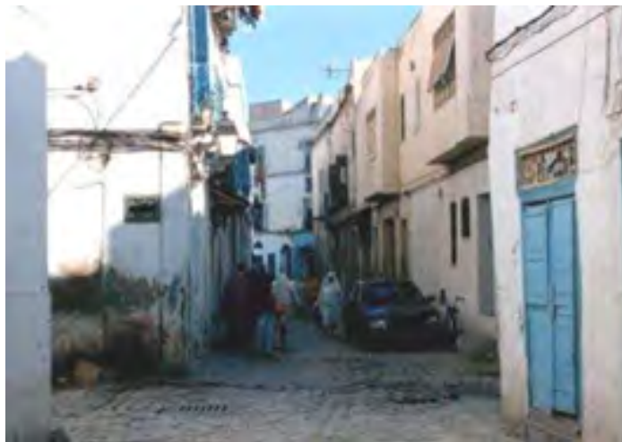
پروژه حفصیه قبل از بهسازی
