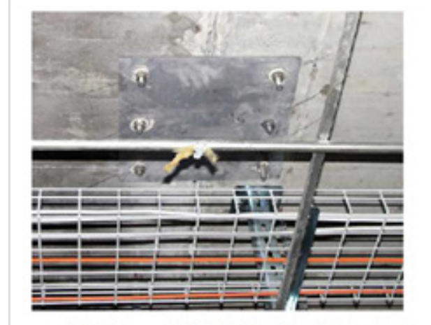
استاد درزهای اتصالاتی در کف طبقات با تعبیه ورق های فولادی در هر دو وجه آنها
