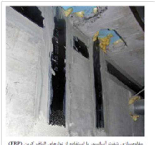
مقاوم سازی سخت اساسور با استفاده از تورهای الیاف کربن (FRP)
