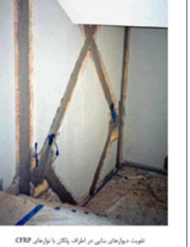
تقویت دیوارهای بتنی در طرف پلان با تورهای CFRP
